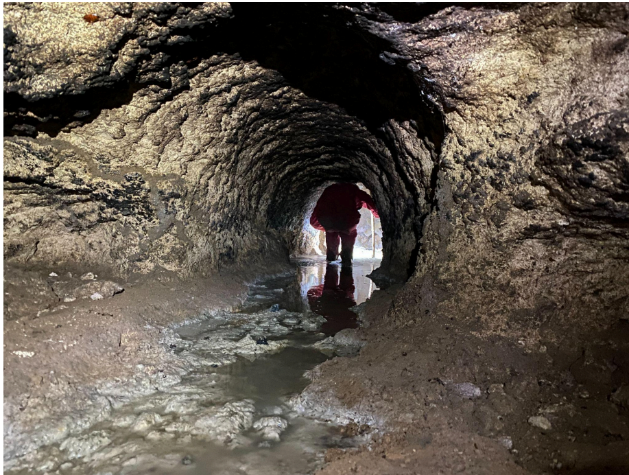
Foto 11.- Detalle del interior túnel.
