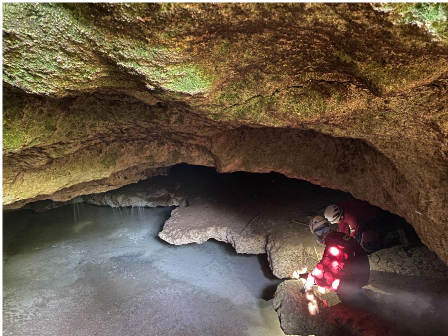
Foto 9.- Sección norte que conduce al túnel. Se puede observar el agua residual que cae como cascada y el fango en la parte inferior.
