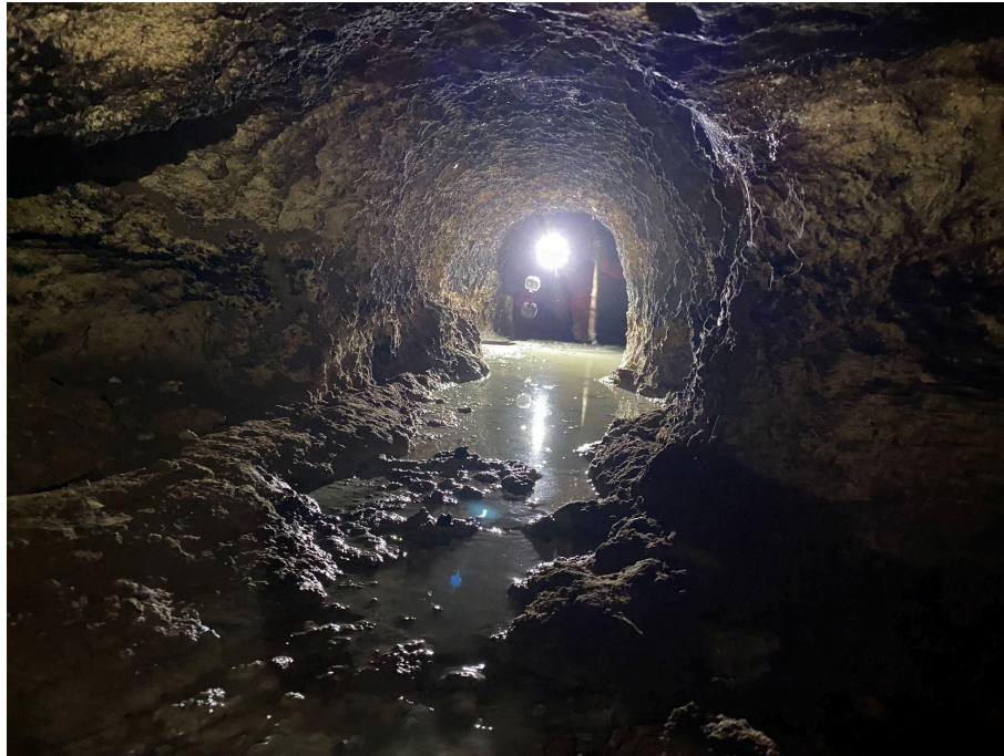
Foto 10.- Detalle del interior túnel.
